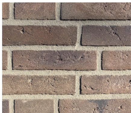
Boomscheut – blok 1 en 2 + kader rondom entree bouwnummer 14 t/m 16
